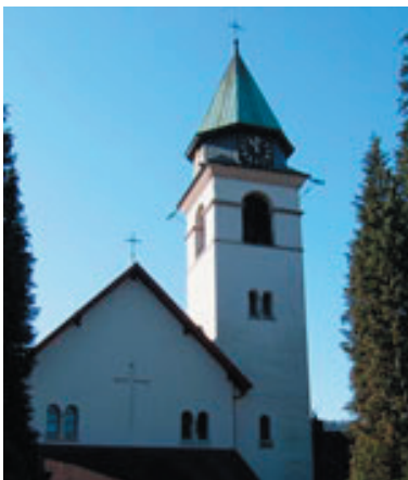
Kirche mit installiertem AFILS System
